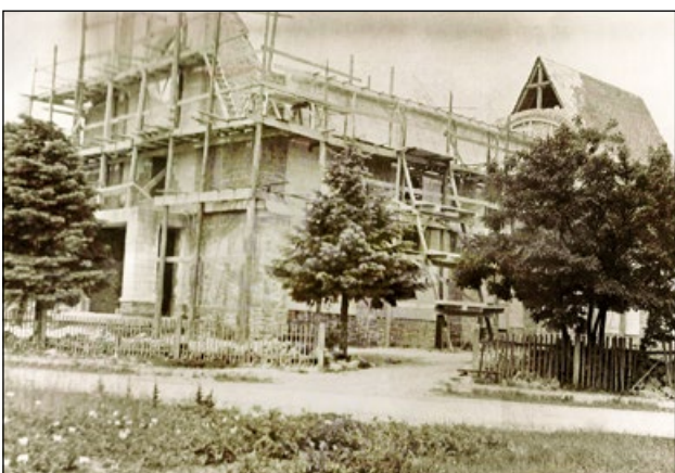
Kościół w czasie budowy, 1960 r., arch. par.
