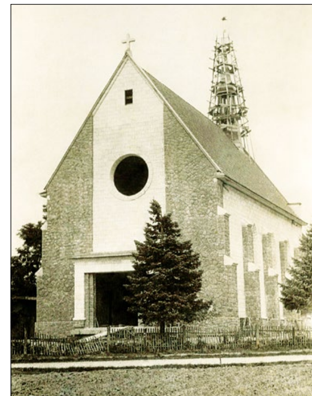
Kościół w czasie budowy, 1961 r. Arch. A. Kukielki.
